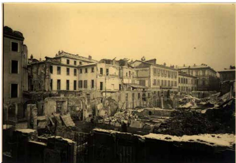
2. Lavori di demolizione dei fabbricati per la realizzazione dell'attuale via Dante a Milano, ripresa fotografica post 1884 ante 1890 (Civico Archivio Fotografico, Raccolte Grafiche e Fotografiche del Castello Sforzesco, Milano).
